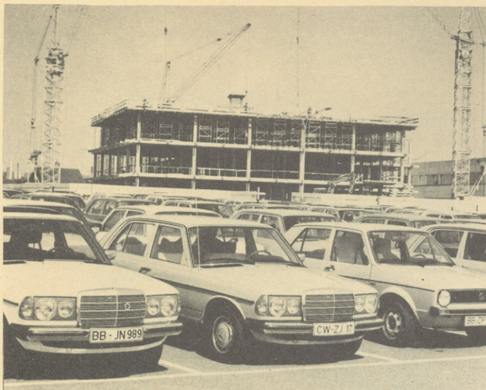
Zahlreiche Baustellen auf dem Werksgelände
